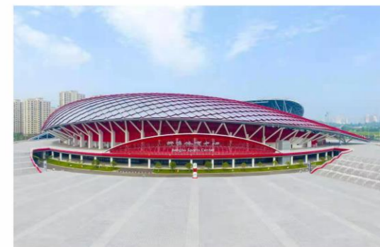
蚌埠体育中心龙鳞金属屋盖空间结构,获安徽省科技进步一等奖
